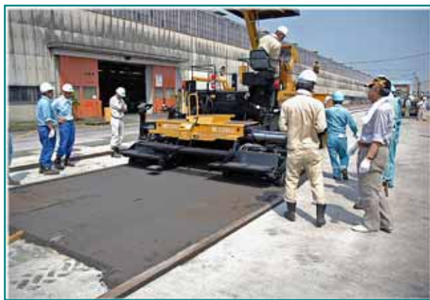
【写真-6:本格的なアスファルト舗装実技研修】
