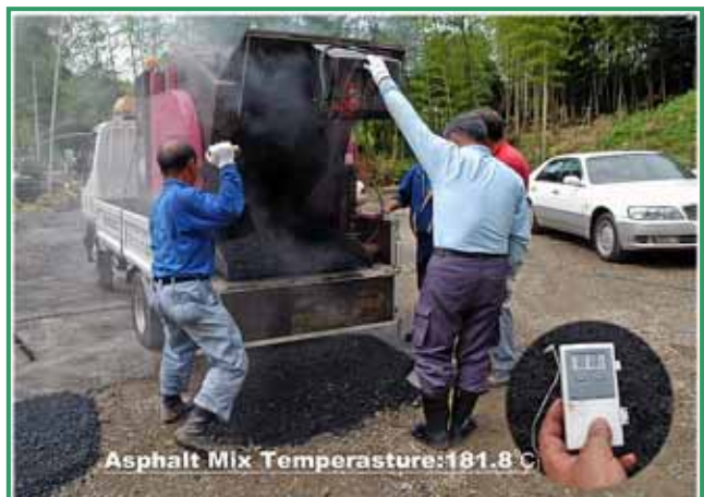
【写真-13:プラントで再生されたアスファルト合材】
