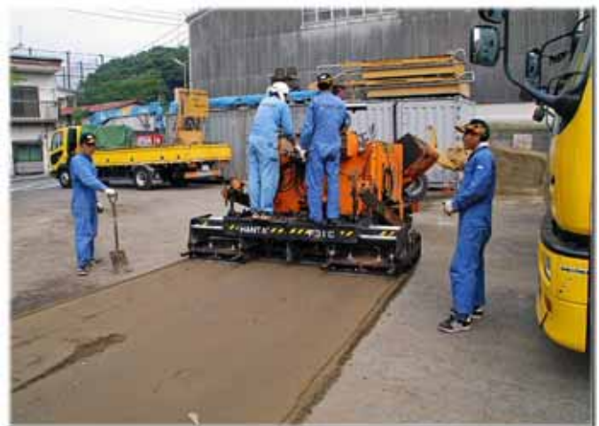
【写真-1:路盤材を使った舗装技術訓練をする研修生】
