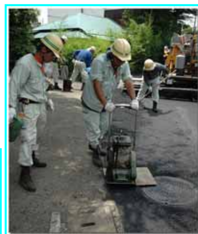
【写真-38:(左上)プレートコンパクタ】 【写真-39:(左下)ローラ転圧作業】 【写真-40:(右上)プレートコンパクタ作業】 【写真-41:(右下)レーキ作業】
