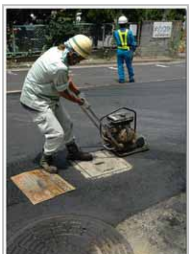
【写真-38:(左上)プレートコンパクタ】 【写真-39:(左下)ローラ転圧作業】 【写真-40:(右上)プレートコンパクタ作業】 【写真-41:(右下)レーキ作業】
