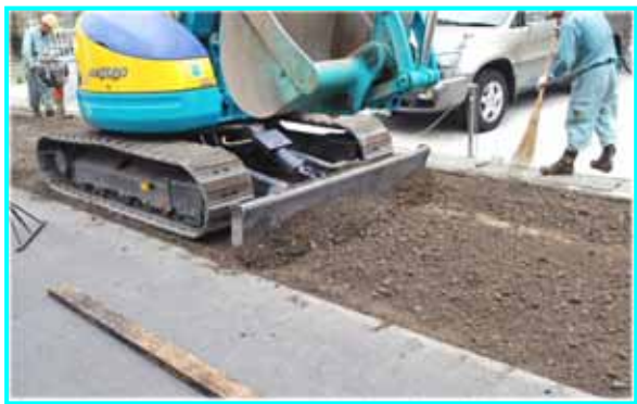
【写真-59:路盤材補給後の敷き均し作業】
