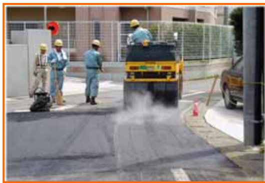
【写真-60:アスファルト転圧仕上げ作業】
