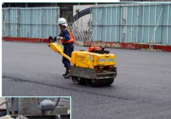
【写真-51(上): ハンドガイドローラ】 本駐車場の舗装工事のような広大なアスファルト舗装現場でも、小さなハンドガイドローラが活躍する。コーナーや継ぎ目、大型ローラの踏み残し部分等活躍の場面が多い。
