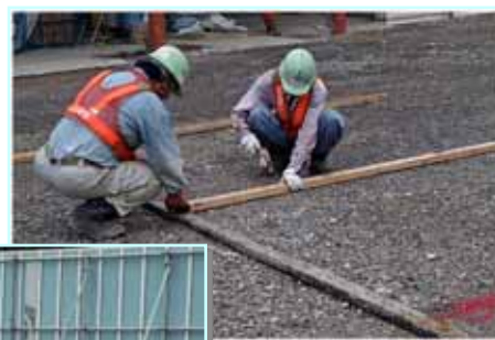
【写真-48(上の左): 型枠を使った大型駐車場のアスファルト舗装】 フィニッシャの最大幅でも敷き均しの余る部分はホイールロードで合材を運んで敷き均し、ローラで転圧して仕上げている。 【写真-49(上の右): 縦横無尽に走り回って転圧している、小型コンバインドローラ舗装厚さが薄いので、小型ローラを使っている。
