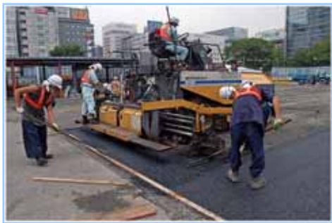
【写真-47(右): 大型駐車場のアスファルト舗装】 耐荷重が少ないので、舗装の厚さはほぼ5cm。
