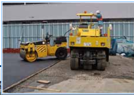
【写真-45(左): 広大な面積のフィニッシャ舗装作業】 【写真-46(右): 大型ローラは、小型ローラの給水車用に使われている】
