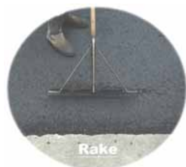
【写真-42:(左)レーキの刃先で、余った合材を処理する瞬間のレーキ作業の妙。】
