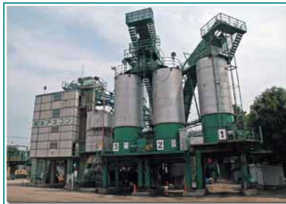
【写真-18: 見学した大型アスファルト合材プラント】
