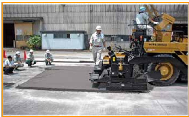
【写真-9: 路盤材を使ったダミー舗装敷均し訓練】
