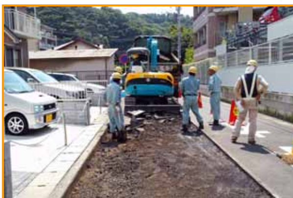
【写真-55:アスファルト舗装を剥がし後の路盤状態】
