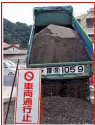
【写真-57:瘦せた路盤材の補給追加作業】
