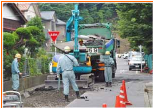
【写真-53:古いアスファルト舗装表層引き剥がし作業】
