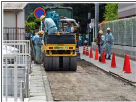
【写真-54:ローラでの路盤材転圧作業】
