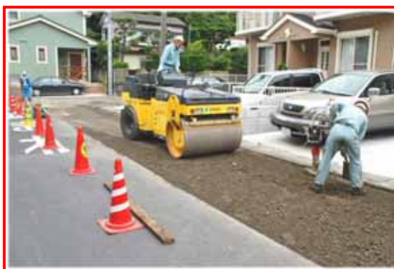
【写真-56:路盤材敷き均し後の転圧作業】
