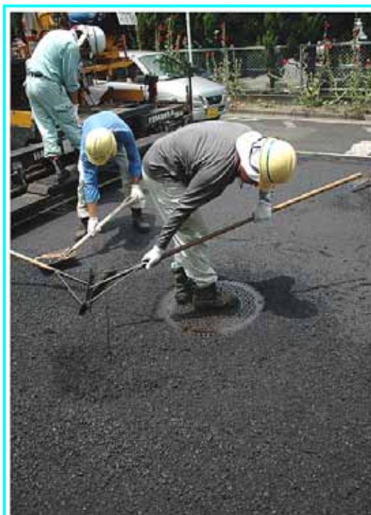
【写真-42:(左)レーキの刃先で、余った合材を処理する瞬間のレーキ作業の妙。】
