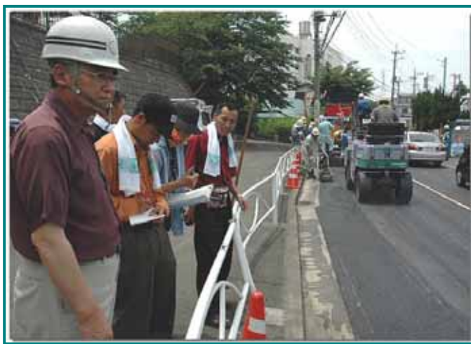
【写真-2:戸塚地方道のアスファルト舗装現場での研修】
