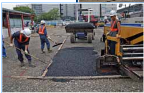
【写真-48(上の左): 型枠を使った大型駐車場のアスファルト舗装】 フィニッシャの最大幅でも敷き均しの余る部分はホイールロードで合材を運んで敷き均し、ローラで転圧して仕上げている。 【写真-49(上の右): 縦横無尽に走り回って転圧している、小型コンバインドローラ舗装厚さが薄いので、小型ローラを使っている。
