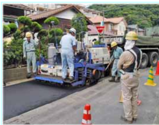
【写真-58:新アスファルト合材の敷き均し作業】
