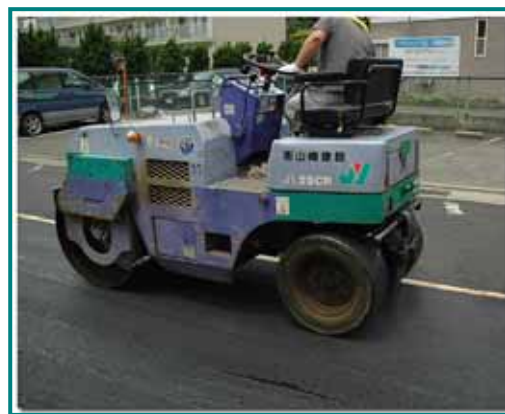
【写真-36:(左)ダンプトラックから合材を受けるフィニッシャ。呼吸を合わせる共同作業。】 【写真-37:(右)ローラ転圧作業。機械のサイズに注目】
