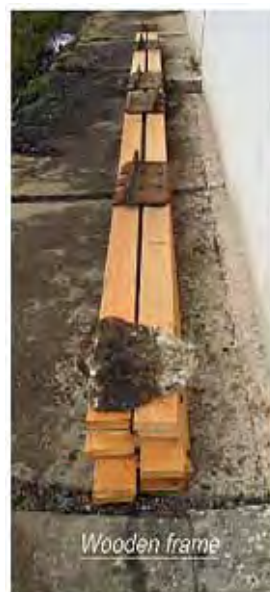
【写真-22: Hesothangkha 工場で作った舗装用型枠】
