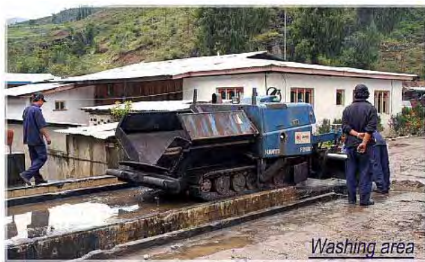
【写真-10: 改修後の洗車と】
