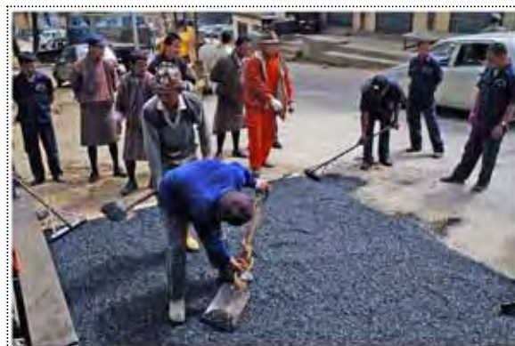
【写真-18: フィニッシャの「台作り」作業】
