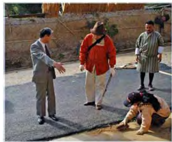
【写真-20: 路盤上の泥を取除く清掃作業】
