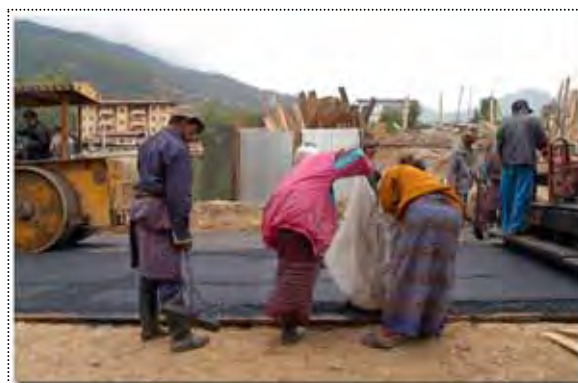
【写真-21: 合材不足部分への補充作業】
