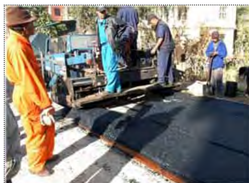
【写真-23: Hesothangkha 工場で作った舗装用型枠の現場での使用例】
