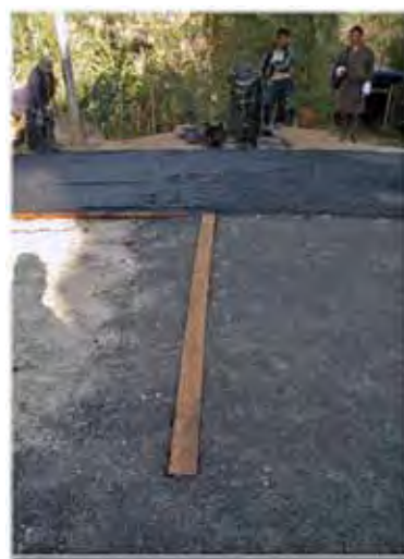
【写真-24 舗装作業の止端用の型枠】
