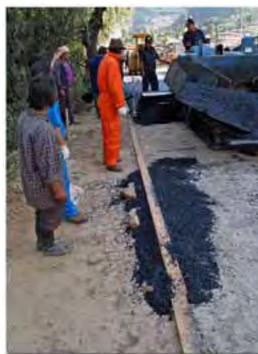
【写真-17:合材を使った型枠水平固定】
