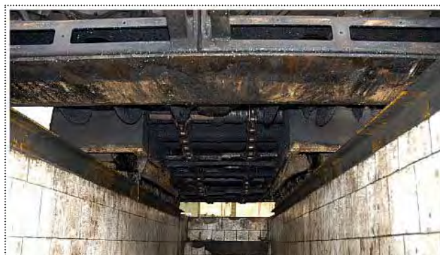
【写真-8:パーフィーダーの合材清掃が済んだPaver】
