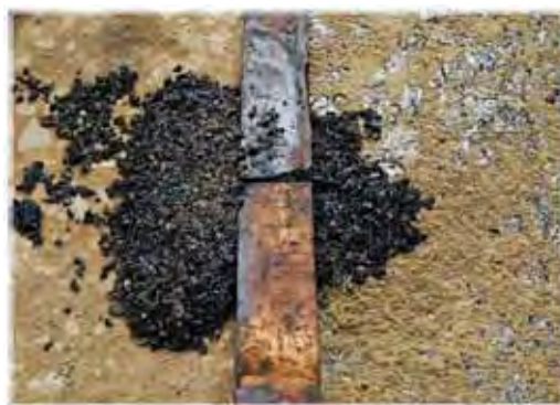
【写真-16:合材を使った型枠固定法】
