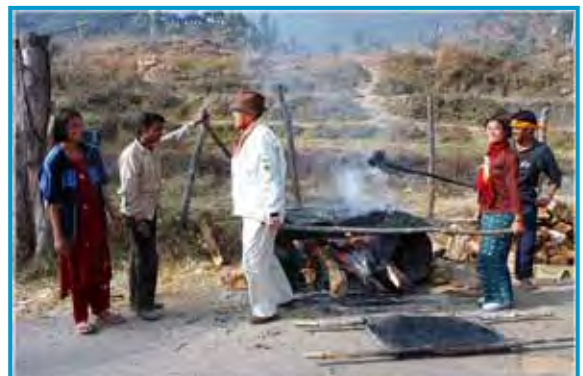
【Photo-43: Mr. Kimura, carrying hot melting asphalt mixture】
