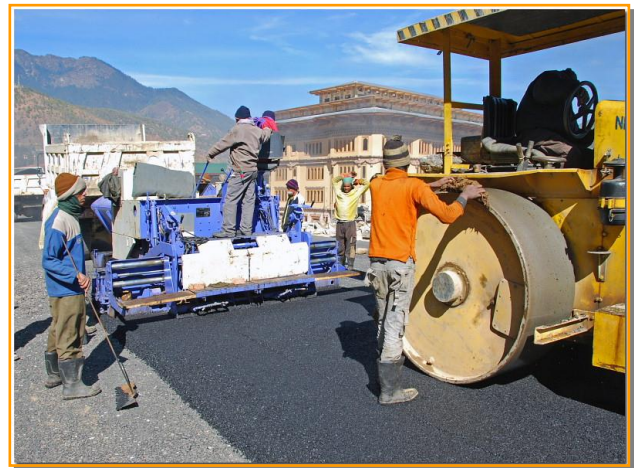
写真5-4 フィニッシャは日本製の高性能の機械だが、ローラは散水装置のないインド製の融通の利かない機械のために、舗装転圧は難儀だった。
