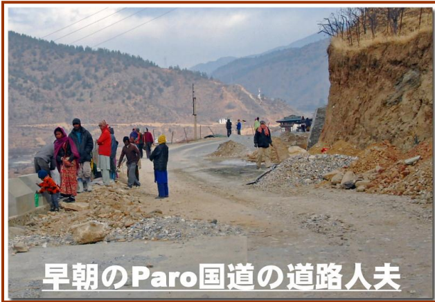
写真 A-2 Paro 空港から Issuna の鉄橋間の高速道路整備現場
