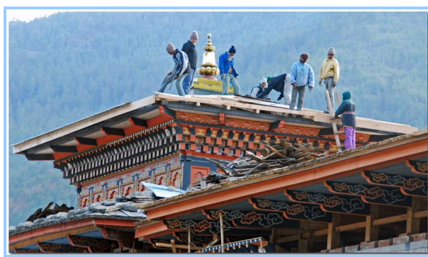
写真8-4 屋根で働くインド人建設労働者
