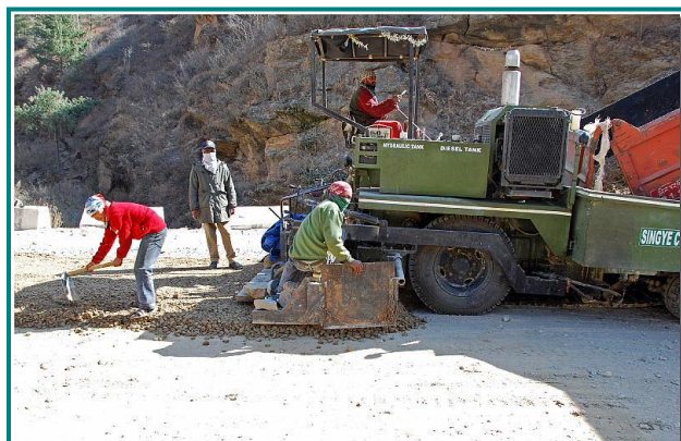
写真6-2 高速道路舗装工事で、フィンリッシュを使った路盤材敷き均し作業
