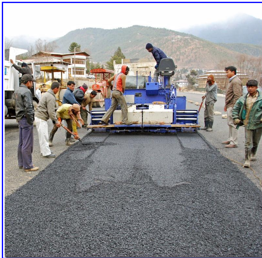
写真A-10 建国100周年記念のパレードが行なわれるティンプ市内の4車線パレードロードの舗装作業
