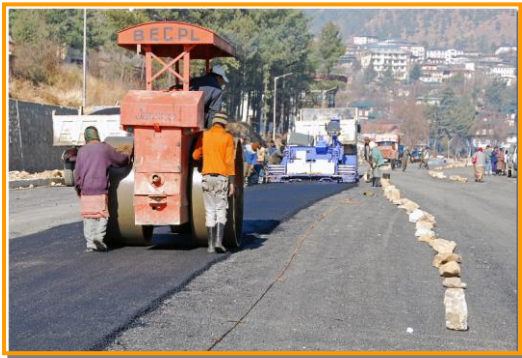
写真A-6 パレードロードの舗装現場 ローラ転圧とフィニッシャへの合材供給。
