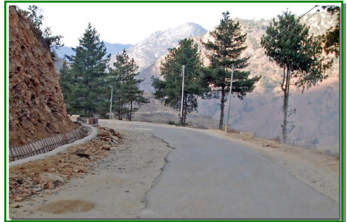
写真 A-3 Chhuzom からThimphu間の高速道路拡張工事
