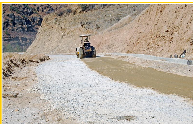
写真6-3 フィンリッシュでの路盤材敷き均し後の転圧作業（ブータンの大手民間企業）
