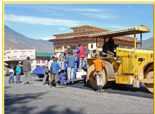
写真A-7 パレードロードの舗装現場 フィニッシャの作業前準備とローラ転圧作業。
