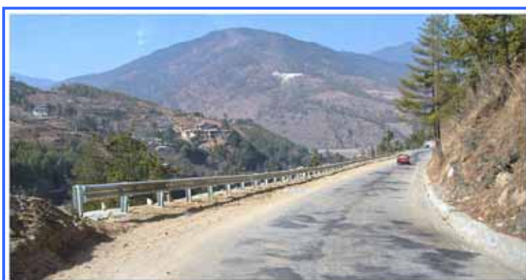
写真 6 - 5 新規ガードレール付国道
