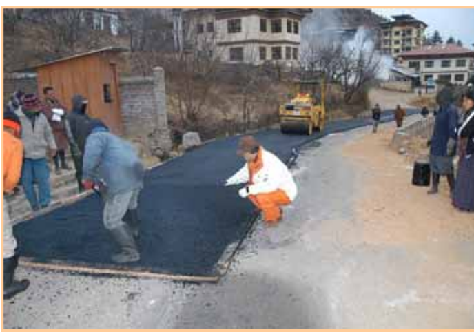
写真5-15 フィニッシャ舗装後の端末処理と、ローラでの転圧指導
