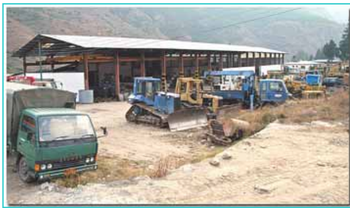
写真8 - 2 道路局ヘソタンカ中央整備工場の全景
