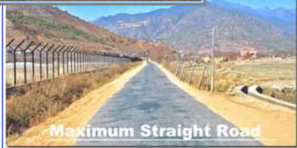
写真 6 - 4 当国で最も直線距離の長いと言われる、パロ国際空港脇の舗装道路（舗装面は継ぎ接ぎが目立つ）
