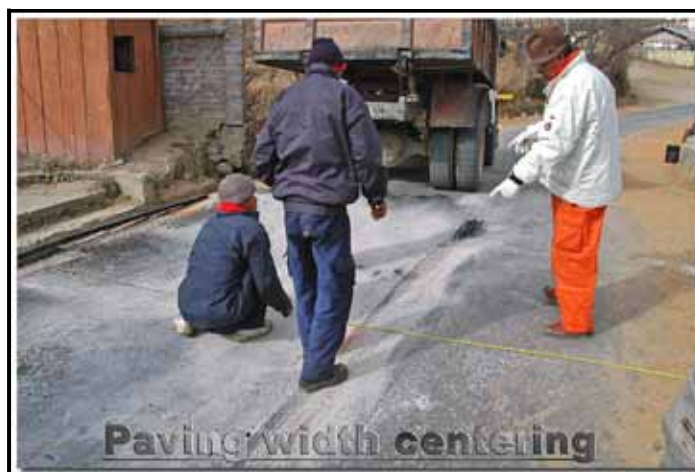
写真5-8 舗装機械を入れる道路の「芯の割り出し」
