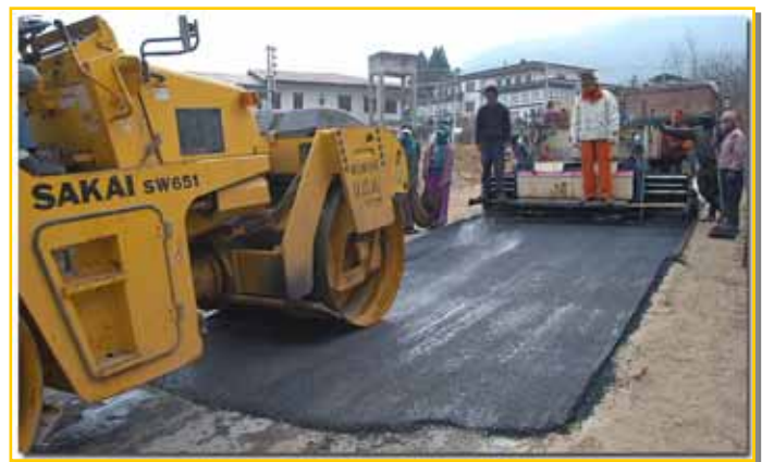
写真 6 - 2 機械舗装施工の実技訓練
