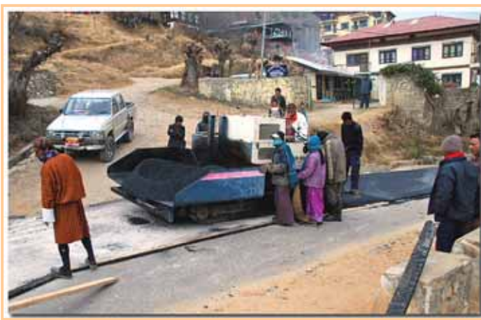
写真5-14 舗装作業の「モデル施工実技」指導
