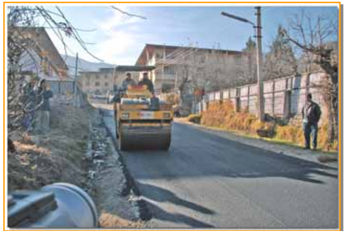
写真5 - 2 日本政府無償資金協力で調達された振動ローラ (質量：6.5 トン)
