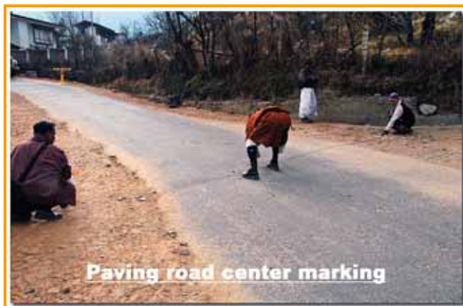
写真 5 - 1 0 舗装路面の計測作業
