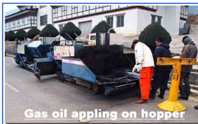
写真5-9 舗装機械の「作業前準備作業」指導
