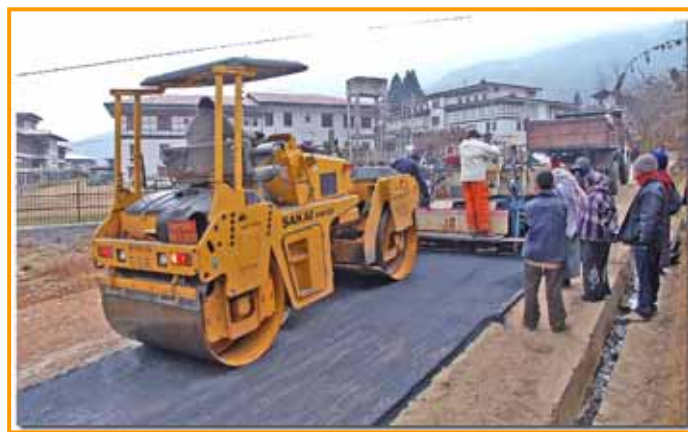
写真 6 - 5 第三次日本政府無償資金協力で調達したローラでの転圧作業と、舗装機械を使って舗装施工実技研修
