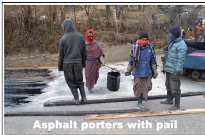
写真6 - 3 舗装作業の補助作業員と使用「型枠」
