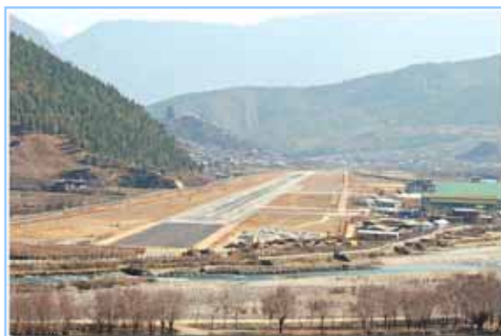
写真 6 - 3 パロ国際空港 全景
