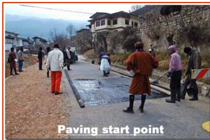
写真5-7 舗装機械を入れる「台」の準備と段取作業
