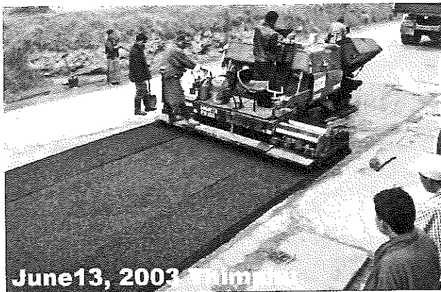
写真1 技術指導前のフィニッシャー舗装
